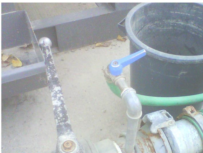
**Figura 1:** posizione del rubinetto **blu** dello sfiato (posizione CHIUSA) per le operazioni di prelievo del percolato dalle cisterne.
